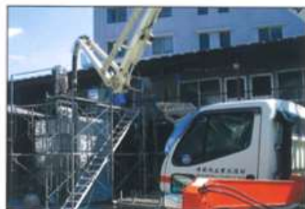
打設側圧試験
