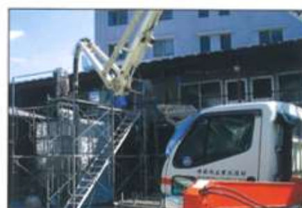
打設側圧試験
