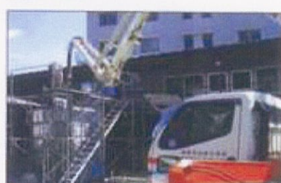
打設側圧試験
